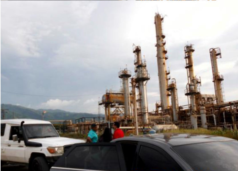
Inspección a las Instalaciones y Centro de Control de la Refinería “Puerto la Cruz”, estado Anzoátegui
