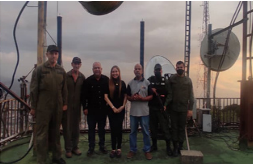
Estación de Antenas de Mecedores
