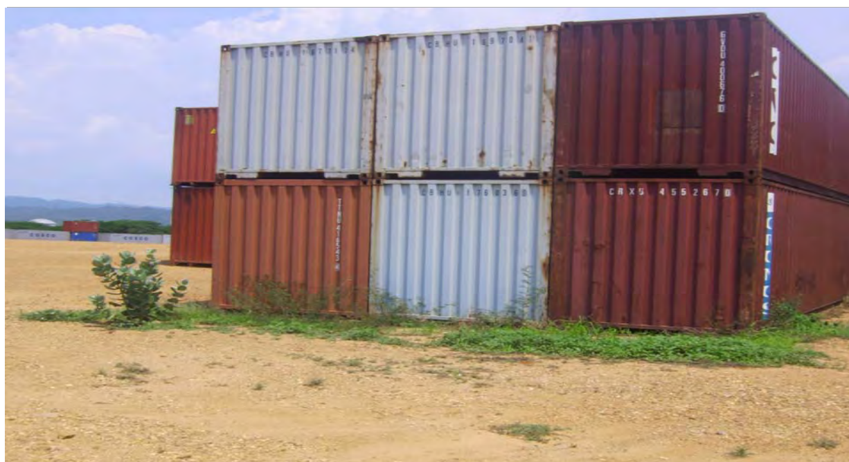
Foto N° 18- Contenedores de alimentos con las paredes deterioradas.
