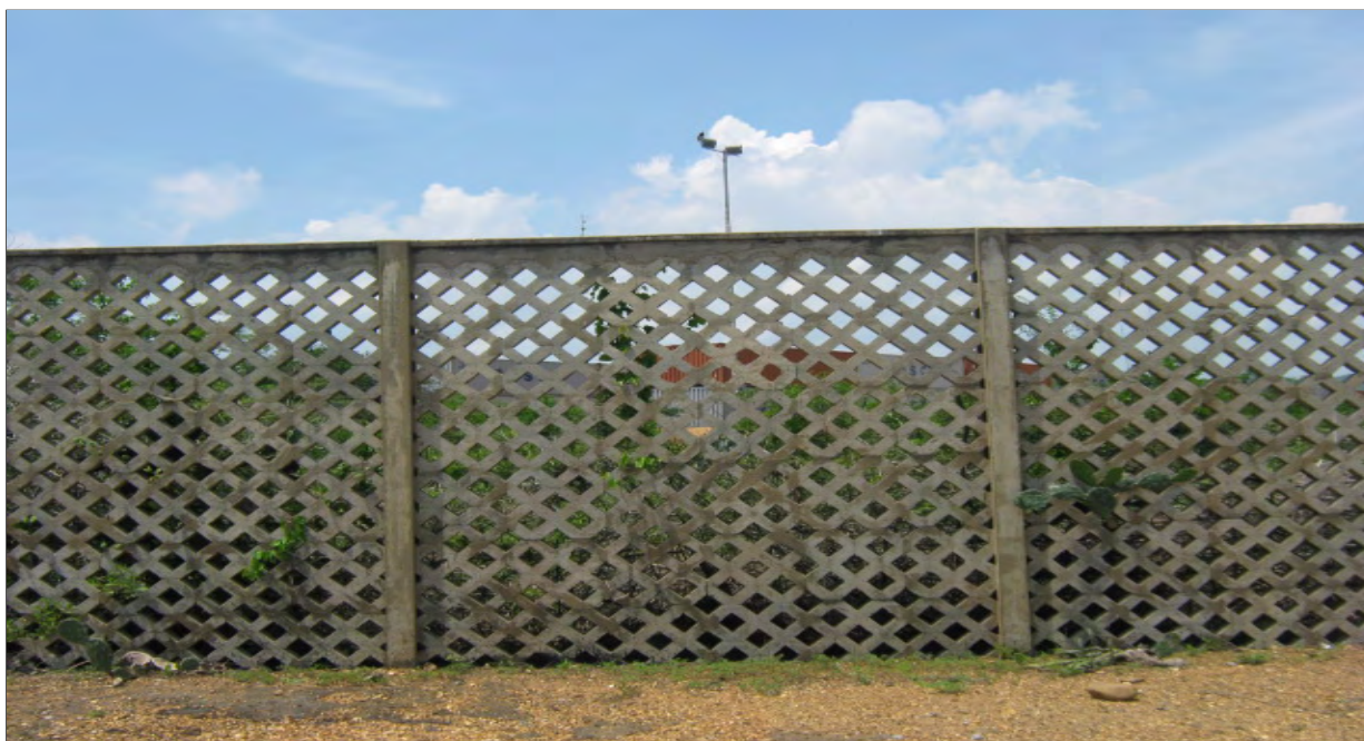
Foto N° 2- Detrás de la pared se observan los contenedores de alimentos.
